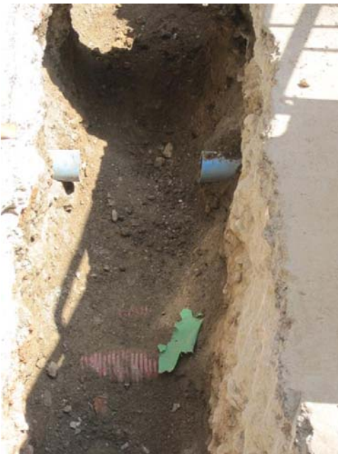
Foto 7 i 8. Vista de les rases entre la rasa general i els edificis. En la foto 7 es poden observar alguns dels serveis que ocupen el subsòl del carrer.
