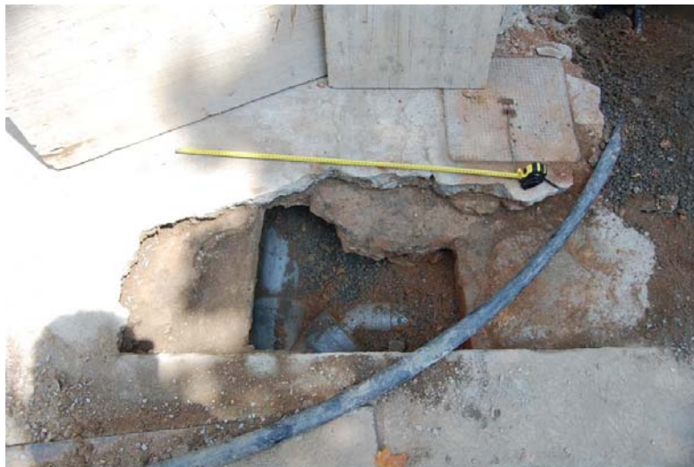
Foto 9. Vista del col·lector UE 107. Es poden observar el diferents tubs de PVC
