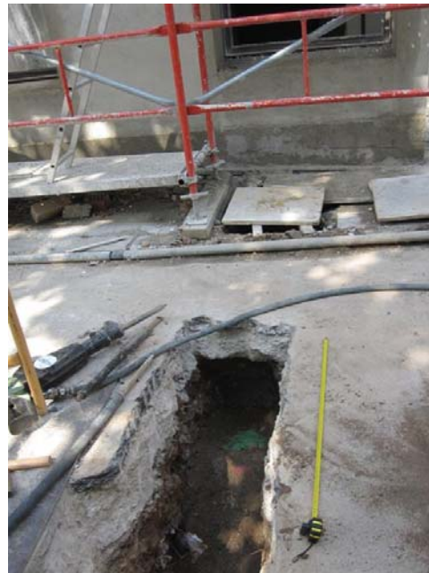
Foto 7 i 8. Vista de les rases entre la rasa general i els edificis. En la foto 7 es poden observar alguns dels serveis que ocupen el subsòl del carrer.
